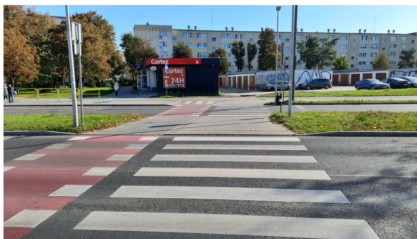
Fot. 12.6. Widok na niebezpieczne miejsce w ciągu ul. Magnuszewskiej
