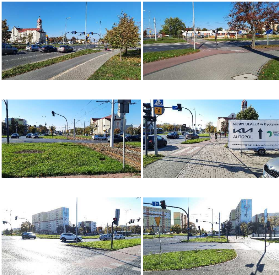
Fot. 12.10. Widok na skrzyżowanie Trasy Uniwersyteckiej i ul. Wojska Polskiego
