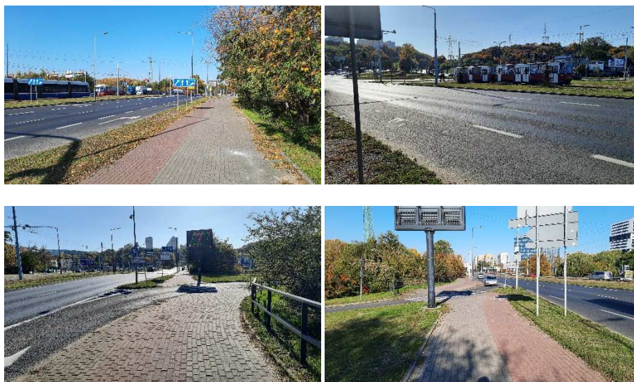
Fot. 12.20. Widok na ul. Wyszyńskiego (Most Pomorski)
